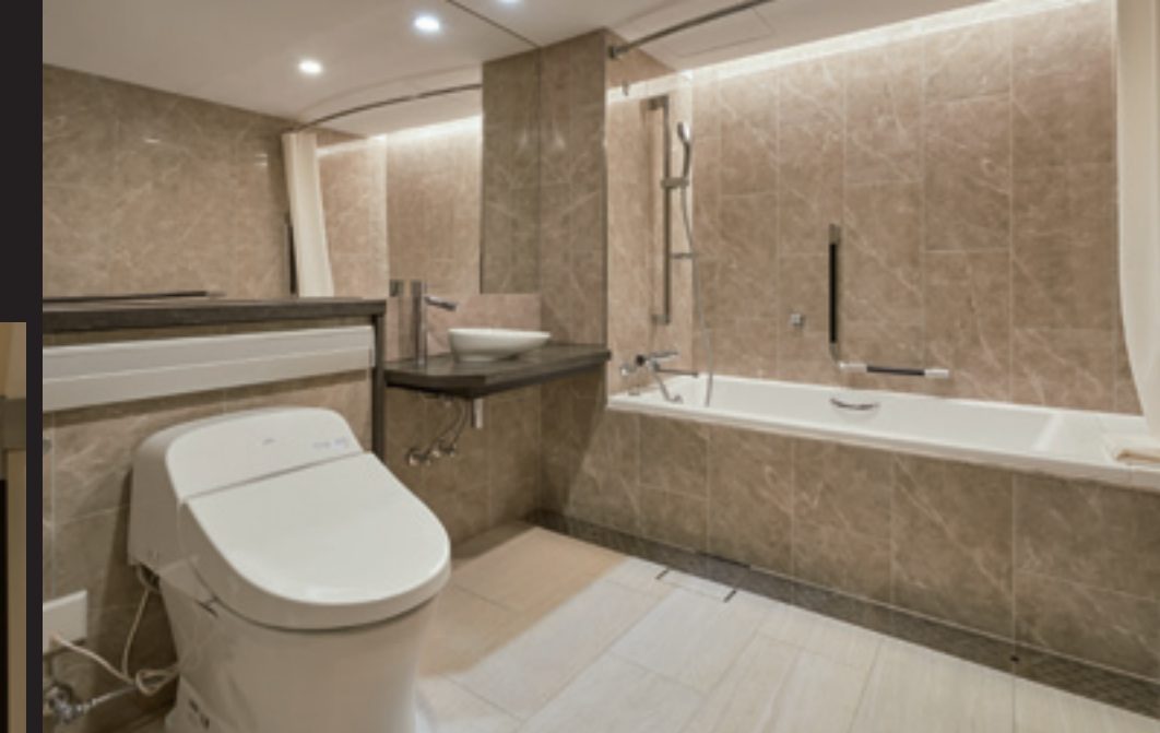
▲同室 取り外した様子
