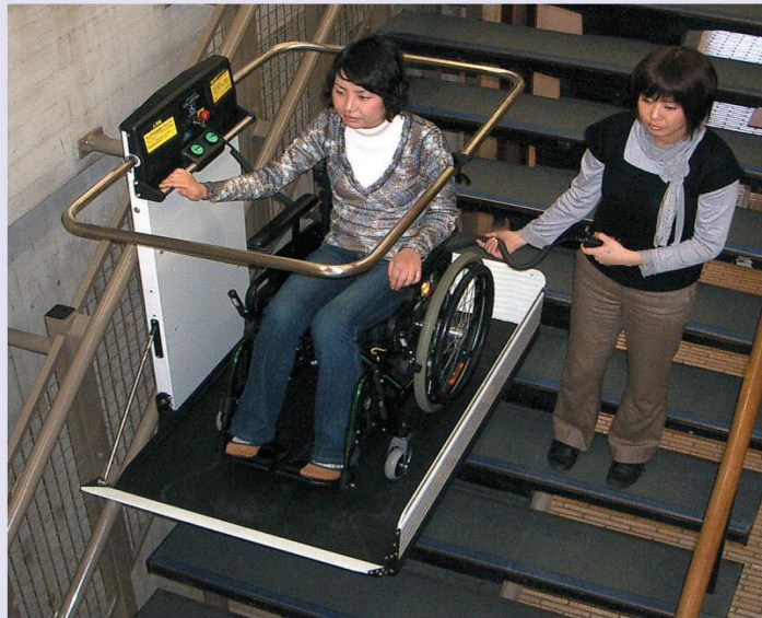
③ 昇降ボタンを押し続けて、リフトを操作します。
