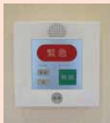
緊急通報装置
