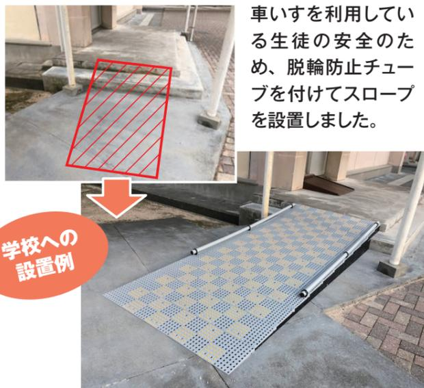
車いすを利用している生徒の安全のため、脱輪防止チューブを付けてスロープを設置しました。
