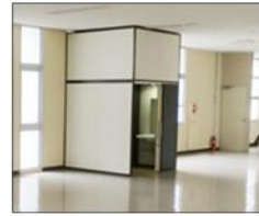
床配管の必要ない、工事の簡単なユニット型水洗トイレ
