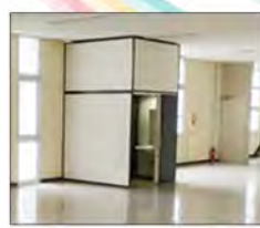
床配管の必要ない、工事の簡単なユニット型水洗トイレ
