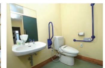
▲トイレは、車いすや手すりが必要な方に使いやすいバリアフリー設計。
