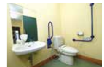
▲トイレは、車いすや手すりが必要な方に使いやすいバリアフリー設計。
