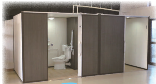
床配管の必要がなく、工事が簡単 ユニット型トイレ
