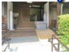
▲寺院の段差解消
